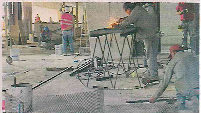
Con maquinaria, materiales y varios trabajadores, se labora a marcha forzada ante su posible reapertura hoy.
