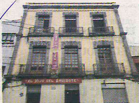
· Localizado en la calle de Colombia 42
