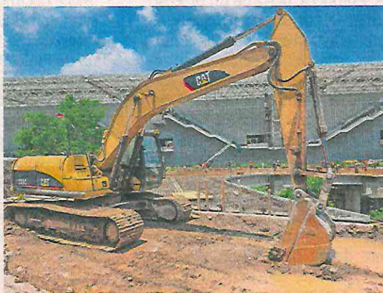
En la zona también hay gran presencia de maquinaria culminando las obras en la estación del Interurbano.
