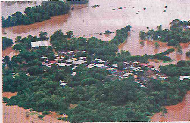
Damnificados aseguran que el agua les sobrepasa la cintura en Tlacotalpan. En José Azueta también están inundados.
