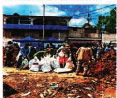
Se prevé colocar 3 mil 500 costales en la colonia Ejidal San Isidro.
