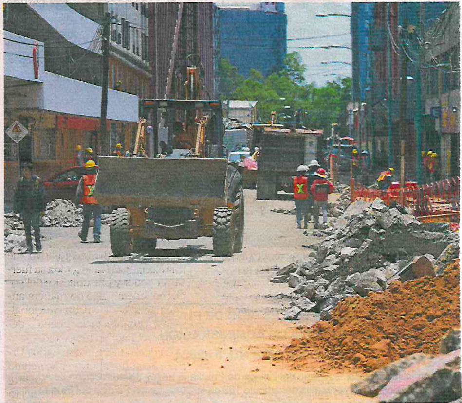
En calles aledañas a la obra se demolerán y reconstruirán 5 mil 207 metros cuadrados del arroyo vehicular y 3 mil 284 metros cuadrados de banquetas.
