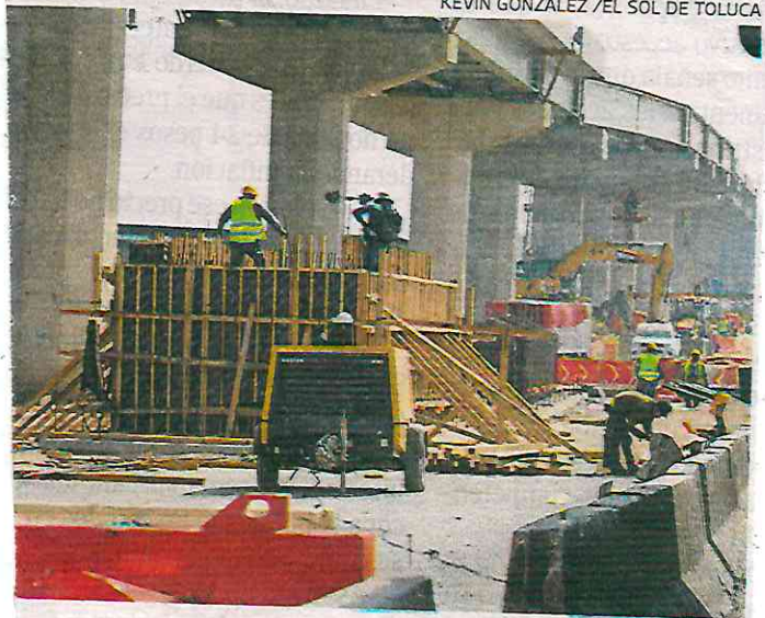
Las obras del tramo elevado provocan caos vial en la México-Puebla
