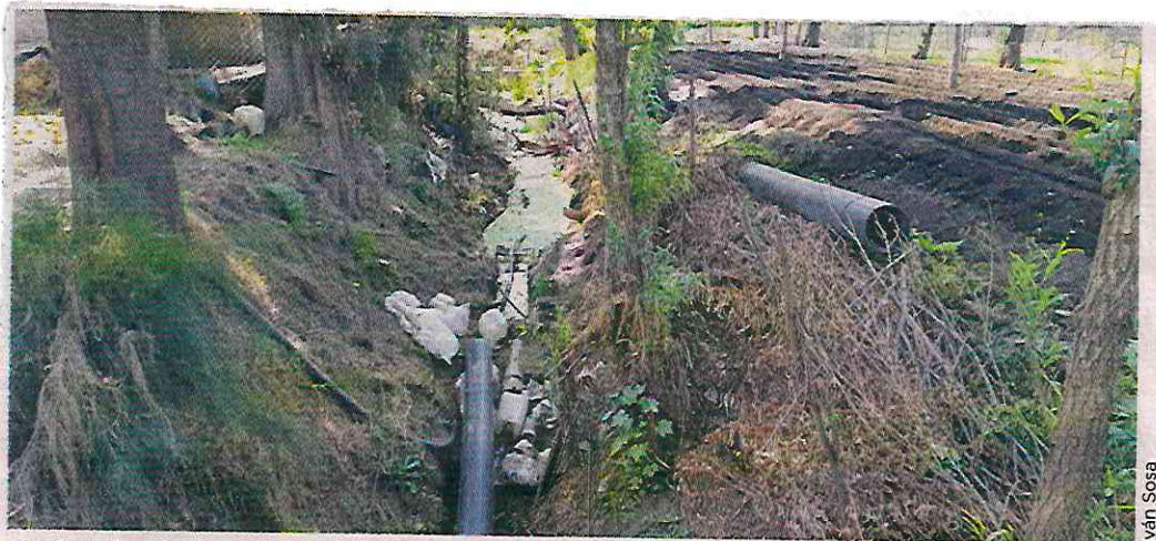
La instalación de un tubo de polietileno de alta densidad en los canales quedó inconclusa por el Gobierno de la Ciudad, afectando el servicio en el área chinampera de Xochimilco.
