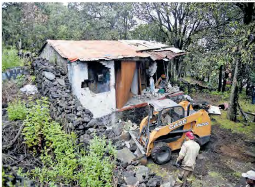
El gobierno capitalino demolió el martes dos viviendas irregulares ubicadas en el kilómetro 7+200 de la Picacho-Ajusco
