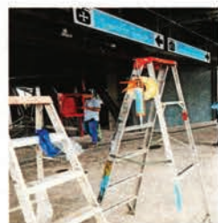
En varias estaciones trabajadores continuaban con las obras.
