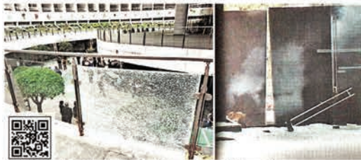
Los petardos dañaron vidrios y un acceso a la Cámara alta.
