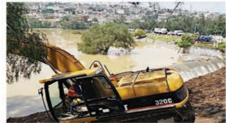
LABORES. Desde la semana pasada, se realizan labores de limpieza en la Presa Los Cuartos.
