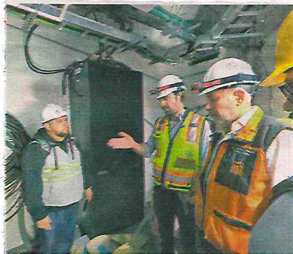
Andrés Lajous y Guillermo Calderón supervisan trabajos en Línea 1 /CORTESÍA: STC METRO
