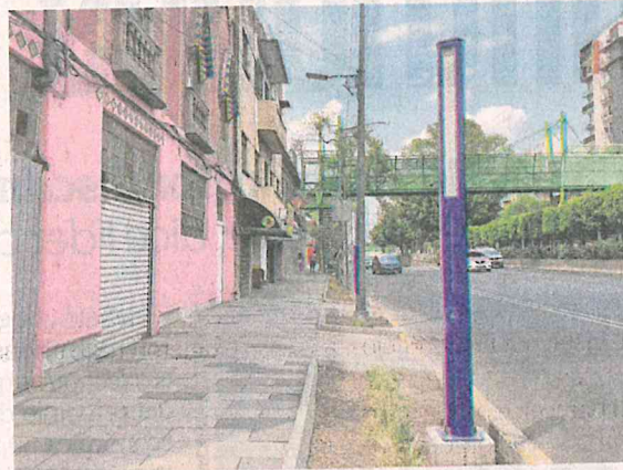
En Tlalpan se realiza sustitución de banquetas, aplicación de pintura en fachadas e instalación de luminarias.
