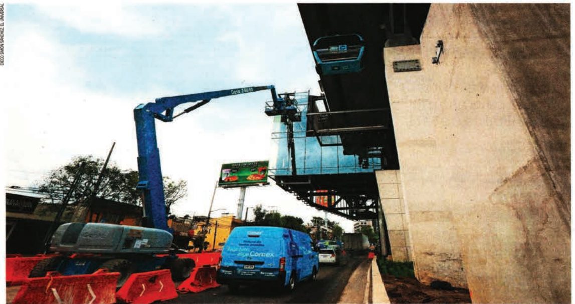
Trabajadores concluían obras en diversas estaciones de la L3 del Cablebús apoyados con maquinaria, lo que afectó la circulación vehicular sobre la avenida Constituyentes.
