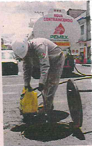
La limpieza de ductos del drenaje y sustitución de tierra continúan.
