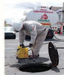
La limpieza de ductos del drenaje y sustitución de tierra continúan.
