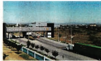
Infraestructura en la zona metropolitana de Monterrey, para impulsar el nearshoring.
