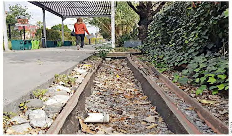
SIN UNA GOTA. Las canaletas del biodigestor se encuentran bloqueadas con azolve.
