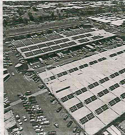
La planta de la CEDA genera 17.5 MW
