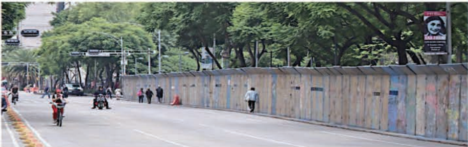
Tan súbita fue la instalación del cerco metálico, que no se contempló delimitar espacio para peatones.
