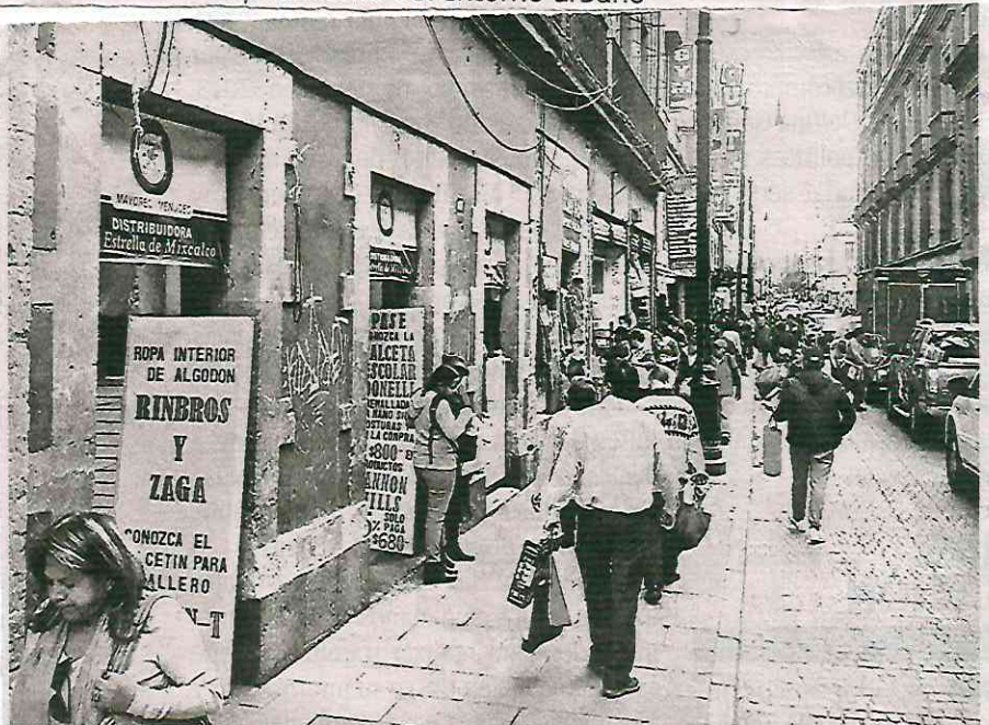
Entre 2019 y 2021 el Instituto de Vivienda de la Ciudad de México (INVI) identificó 51 inmuebles en situación de riesgo, de los cuales 36 se encuentran catalogados como inmuebles patrimoniales
