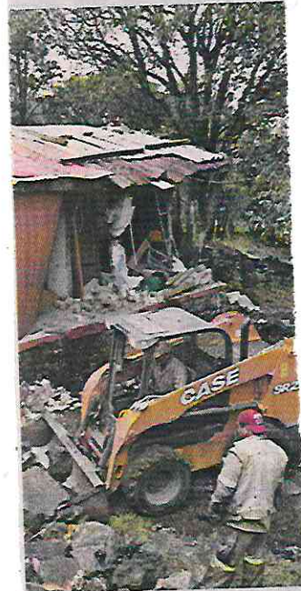
Las construcciones fueron demolidas.
