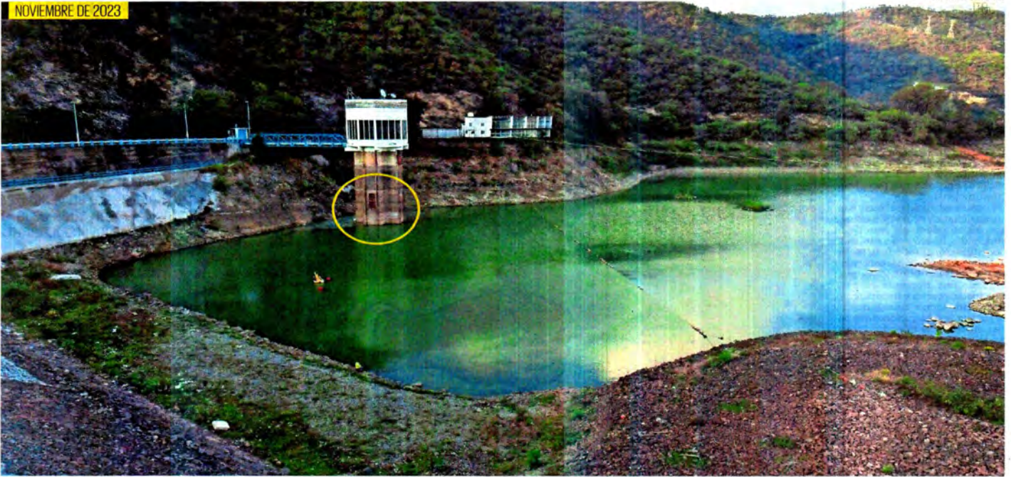
El sistema de captación de agua de lluvia tenía un almacenamiento de 310 millones de metros cúbicos, lo que representaba 41.7% de su nivel de llenado, un déficit de 40% respecto al promedio histórico.
