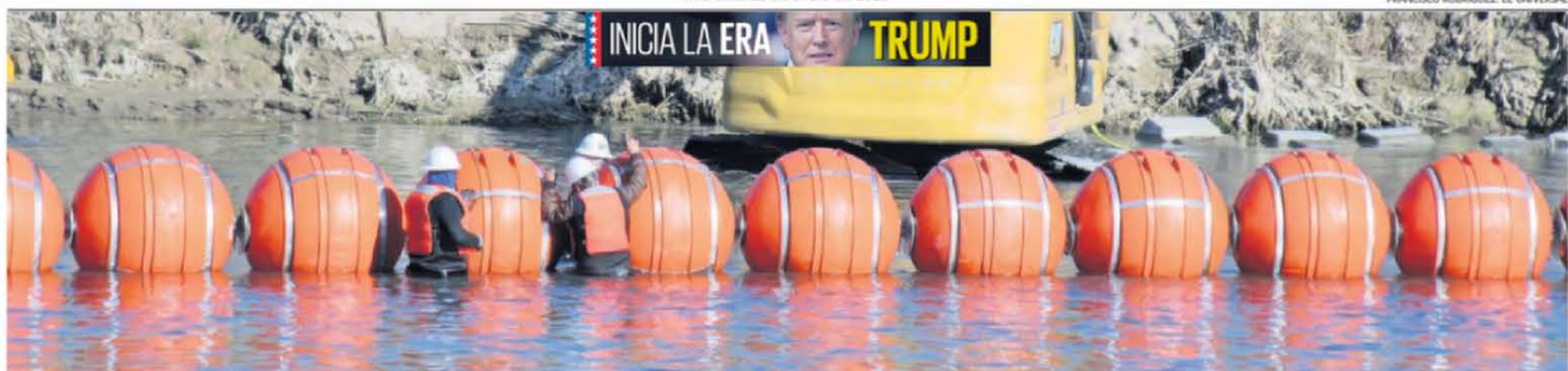
Con maquinaria pesada, trabajadores estadounidenses reforzaban ayer las boyas colocadas en el río Bravo, a la altura de la frontera entre Piedras Negras, Coahuila, y Eagle Pass, Texas. Se prevé que coloquen más. | A7 |
