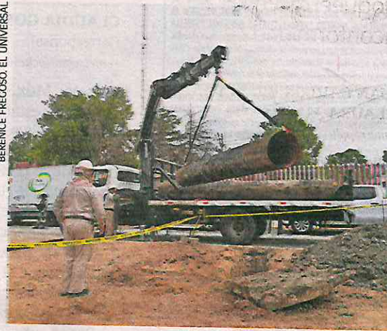
Con ayuda de grúas levantaron los tubos dañados para lijar las partes plagadas de suciedad.
