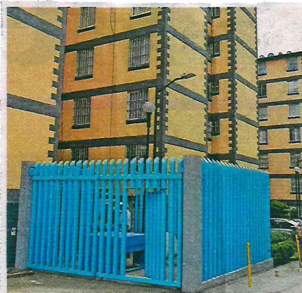
Las obras de rehabilitación del pozo tuvieron una inversión de 2 mdp /CORTESÍA: GCDMX
