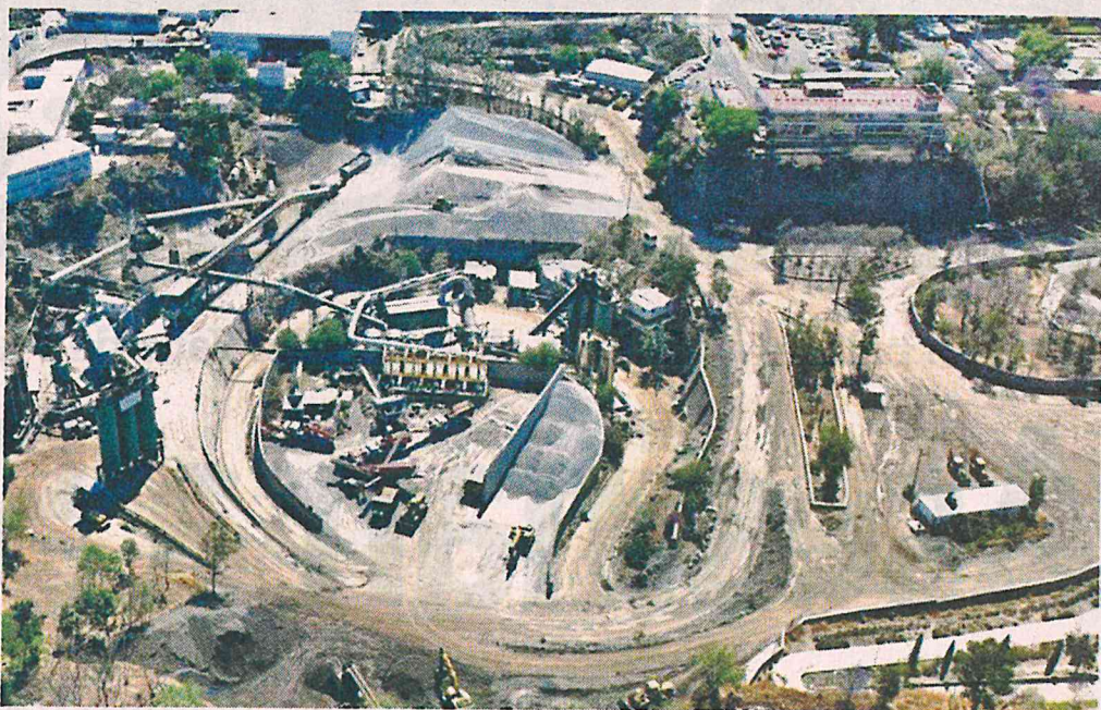
La Planta Productora de Mezclas Asfálticas se ubica en Avenida del Imán, en Coyoacán
