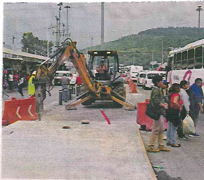
Los usuarios siguen teniendo que esquivar las obras que se realizan en el Cetram.
