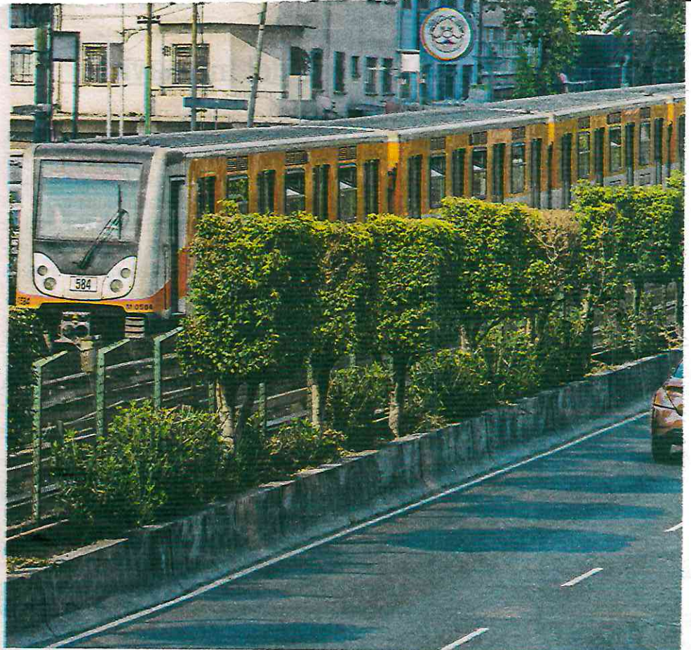
Existen tramos del camellón que lucen totalmente verdes, pero hay otros descuidados
