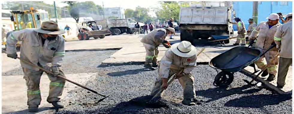
¡BUENOS DÍAS! El ruido de las cuadrillas de asfalto despertó a los vecinos de la Colonia Federal, de las más afectadas.
