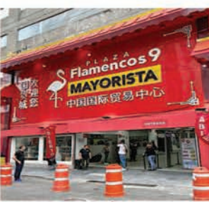
TRANSFORMACIÓN. Los cientos de cajones de estacionamiento fueron acondicionados para operar ahora como locales y bodegas de productos de China.
