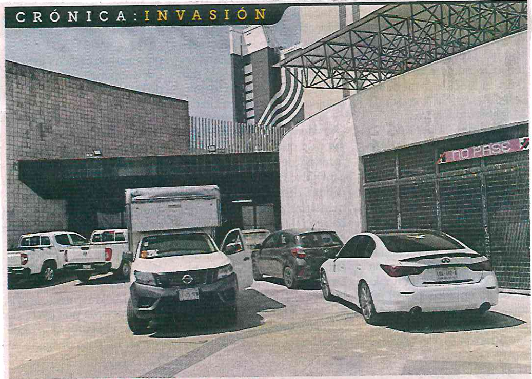
SIN NECESIDAD DE CAJONES. Vehículos particulares fueron colocados en la zona contigua a los accesos a la estación del Metro, la cual se somete a trabajos de renovación.
