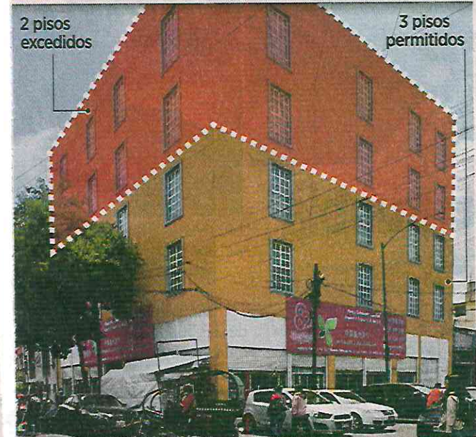
■ Dos inmuebles de la calle Joaquín Herrera, aledaños al Barrio de Tepito, fueron construidos con pisos adicionales a los permitidos por la ley.
