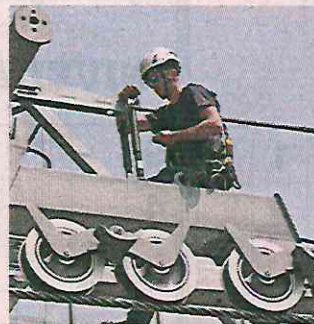
■ Los trabajos en la L-1 de Cablebús finalizarán el 28 de julio.
