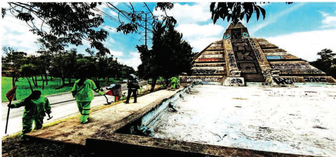
El Monumento a la Raza aún se encuentra vandalizado, grafitado y con daños en su estructura, entre otros detalles.
