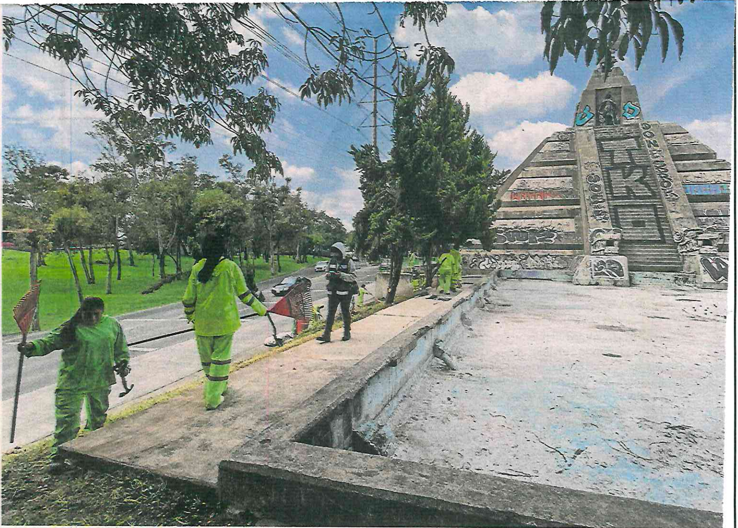
El Monumento a la Raza aún se encuentra vandalizado, grafitado y con daños en su estructura, entre otros detalles.
