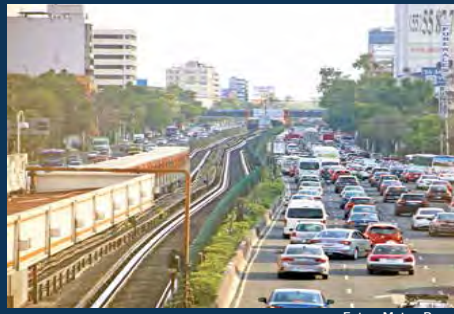
La jefa de Gobierno, Clara Brugada, anunció que el plan es que la obra pase por arriba de la Línea 2 del Metro.
