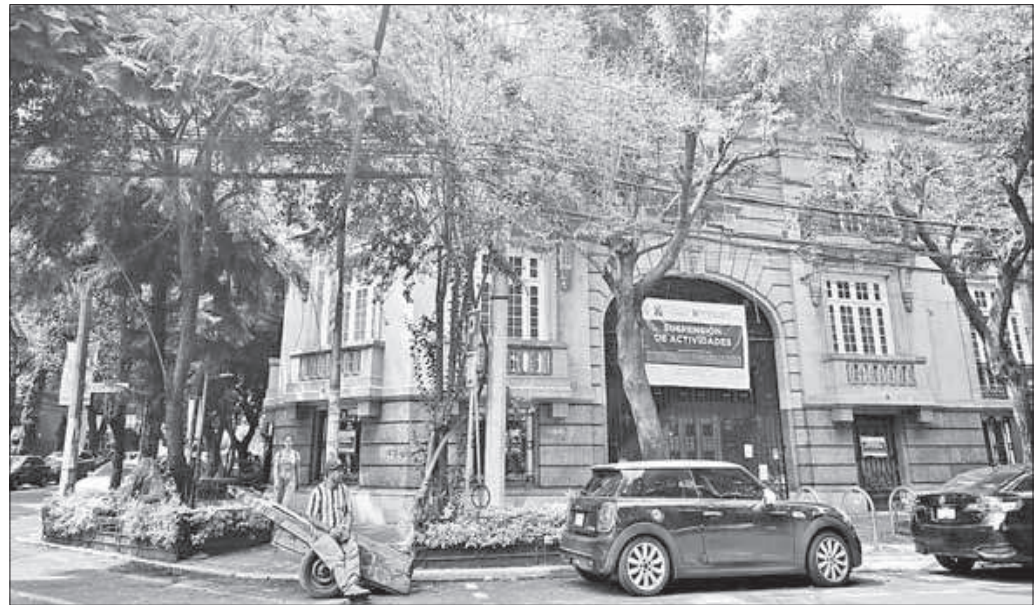
▲ En el inmueble de la calle Colima 233, colonia Roma Norte, se planea construir 15 habitaciones de hotel y un restaurante con servicio de bar en planta baja y tres niveles. La PAOT colocó sellos de suspensión de actividades. Foto Yazmín Ortega Cortés
