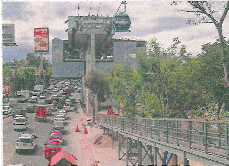
Los trabajos de colocación del nuevo piso continúan en las cercanías de las estaciones Charrería y Panteón de Dolores, constató EL UNIVERSAL.
