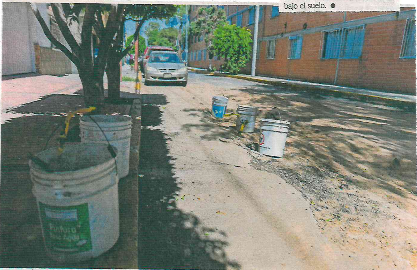
Los túneles han creado hundimientos en las calles de la colonia Gertrudis Sánchez que a simple vista parecen baches y socavones, pero en realidad son consecuencia de los trabajos de extracción ilegal de combustible en las tuberías de Pemex de la zona.
