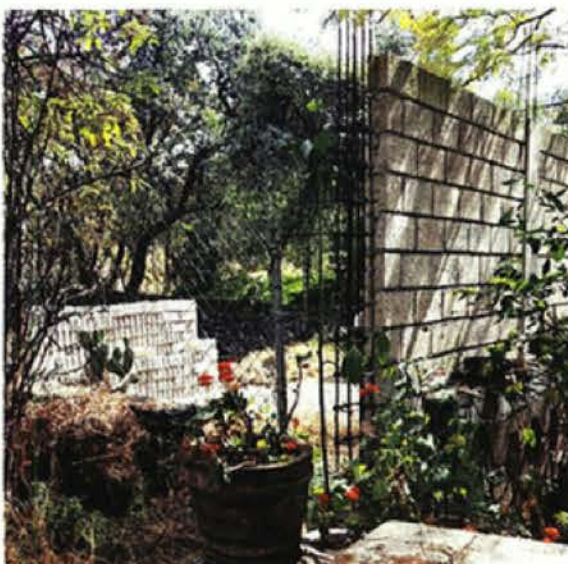
■ Materiales de construcción han sido acarreados al interior del predio ubicado en Tlalpan en los últimos meses.
