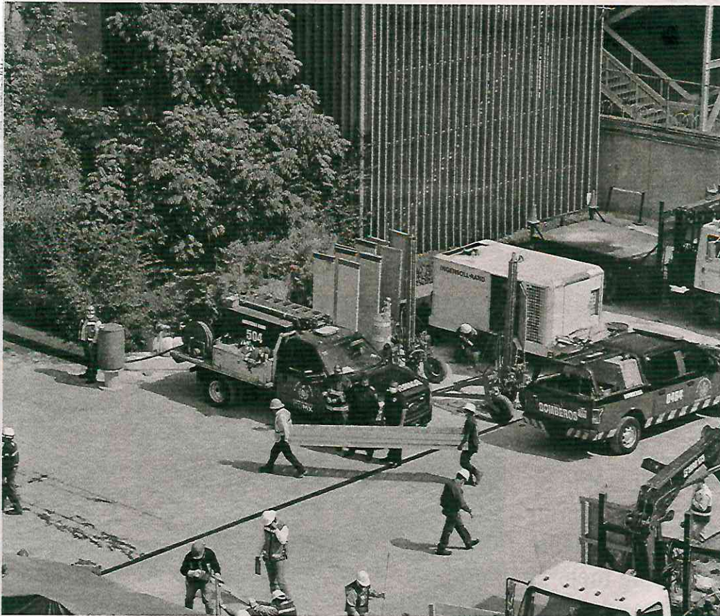
El 9 de enero de 2021 se quemó la Subestación Eléctrica de Alta Tensión
