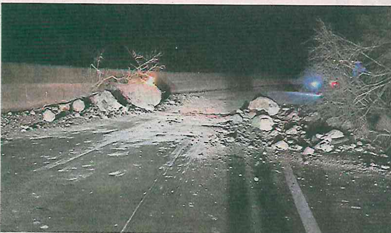
En Colima, las autoridades reportaron un deslizamiento en el tramo de La Salada, sobre la autopista Colima-Manzanillo.
