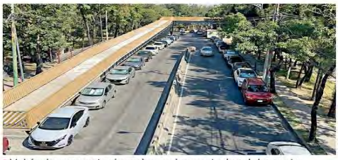
■ Vehículos son estacionados en los costados del puente en construcción.
