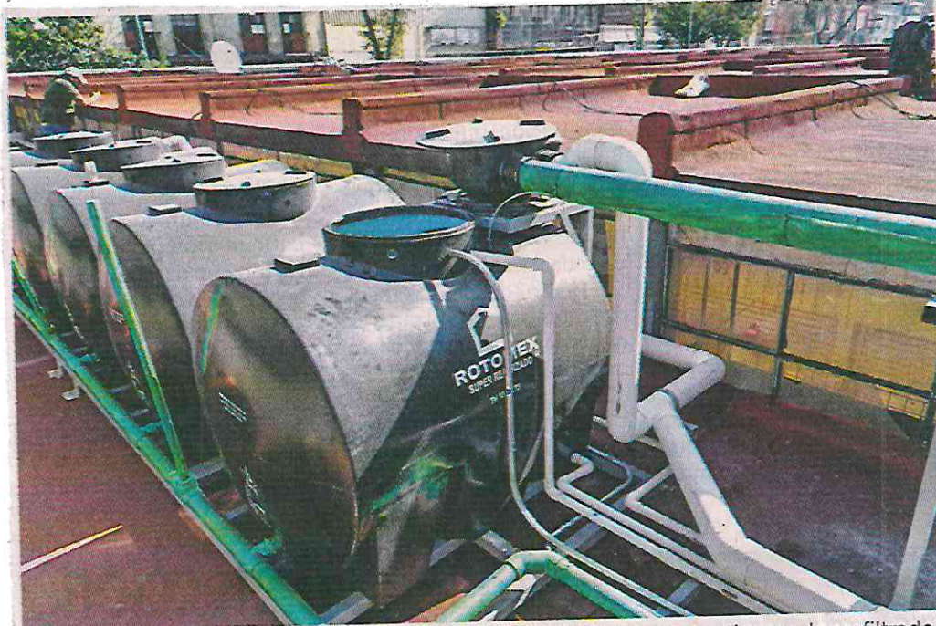
■ En el techo se colocan canaletas que llevan el agua de lluvia hasta estos tinacos de prefiltrado.
