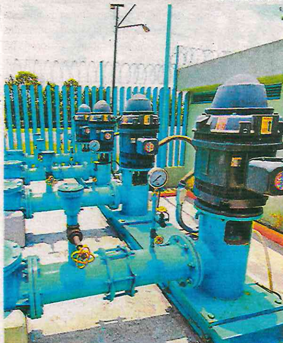
La Secretaría de Gestión Integral del Agua rehabilitará la infraestructura hídrica
