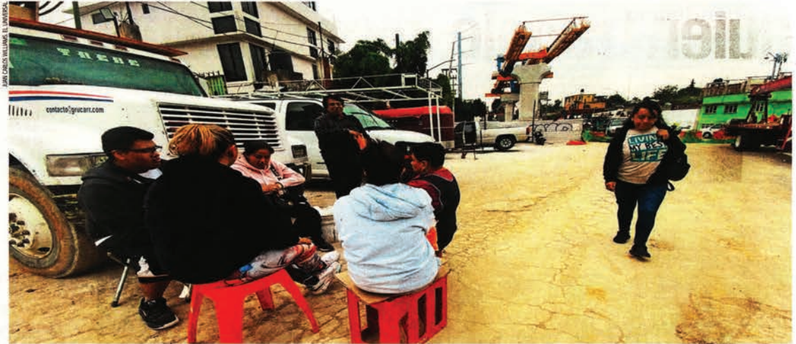
Habitantes de la colonia El Capulín, en Álvaro Obregón, bloquearon nuevamente los accesos a trabajadores de la obra del Tren Interurbano; exigen conocer los dictámenes de riesgo de sus casas y la reparación de los daños para terminar su protesta. | METRÓPOLI | A26
