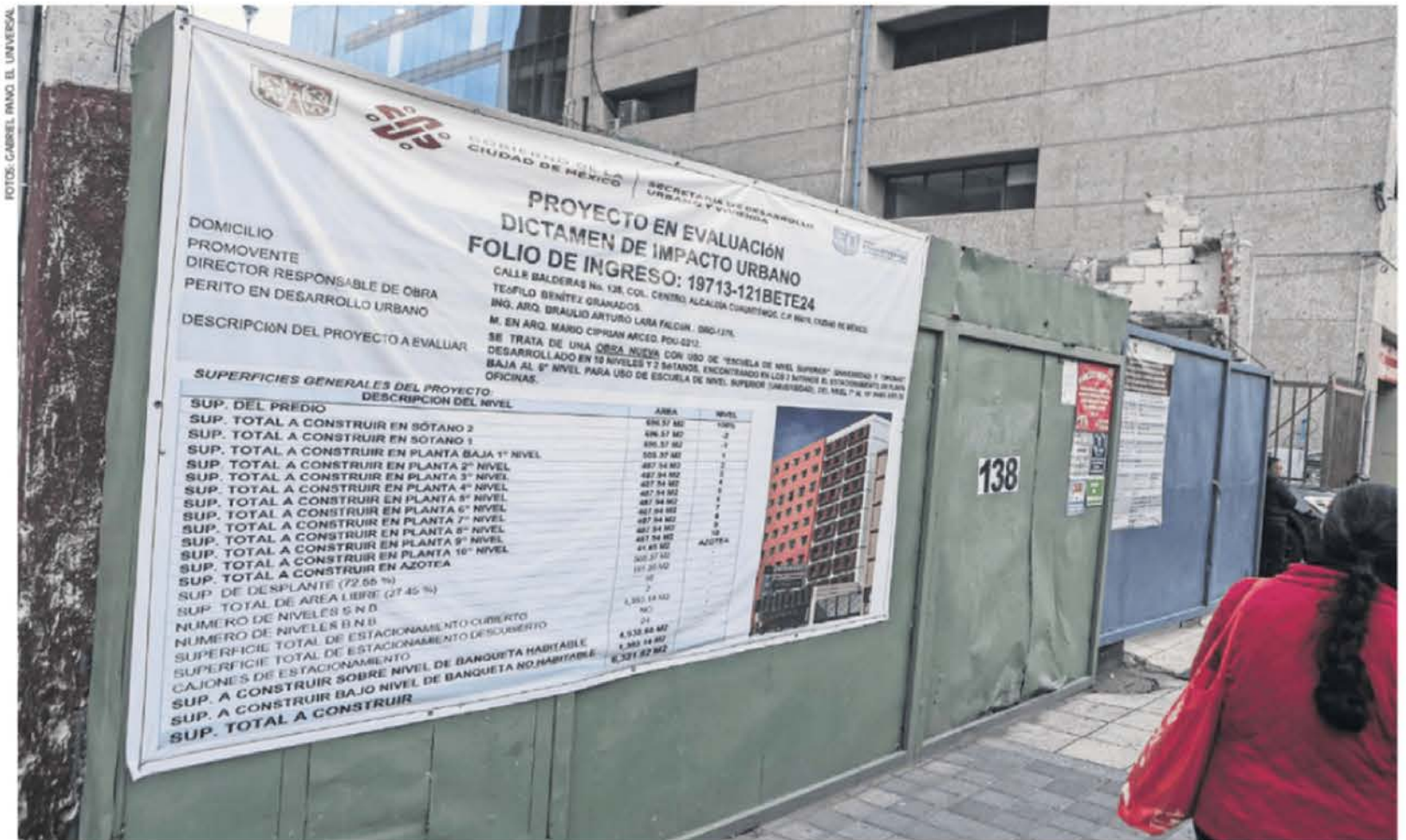
En Balderas 138, en la alcaldía Cuauhtémoc, el proyecto que se analiza es una obra nueva con uso para universidad y oficinas desarrollado en 10 niveles y dos sótanos.
