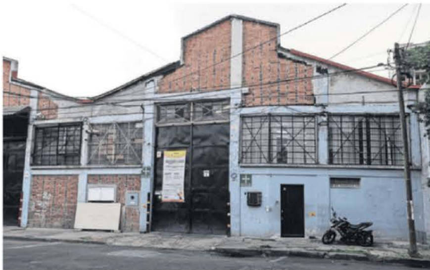
En la colonia Arenal, en Azcapotzalco, se ubican los predios de Chopo 594 y 598; el lugar se ve deteriorado y ahí se pretende construir casas-habitación y comercios.
