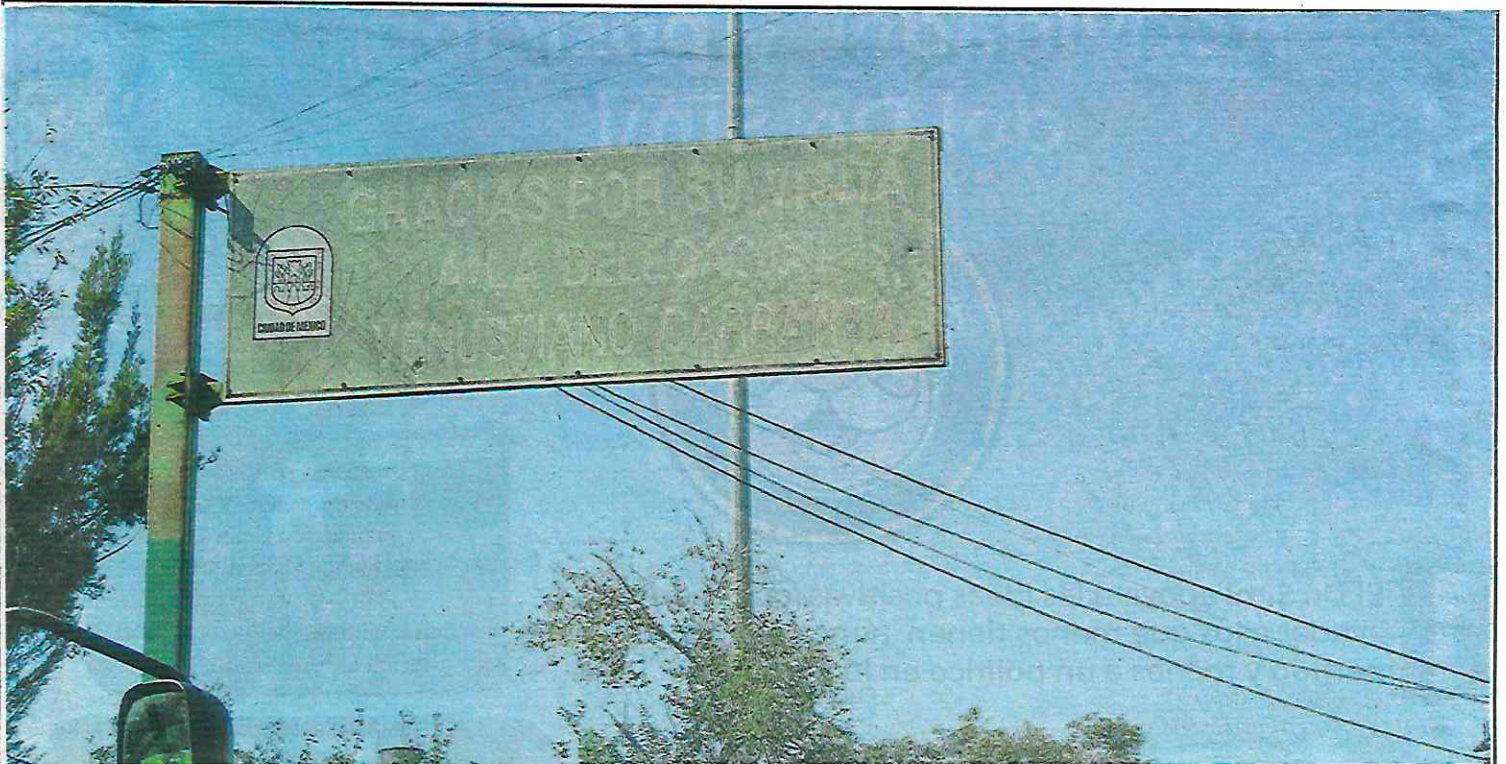
Muchas placas existentes están deterioradas o ilegibles debido a la exposición prolongada al clima, el desgaste o actos de vandalismo.
