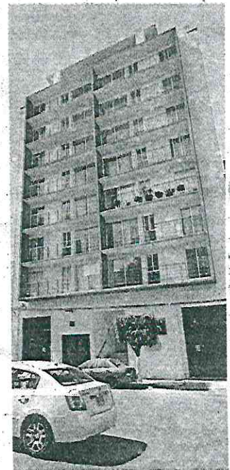
■ El edificio fue entregado, sin embargo, la posesión no se ha concretado.
