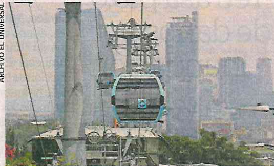
El Cablebús brindó servicio de Parcur/Colegio de Arquitectos a Los Pinos/Constituyentes.
