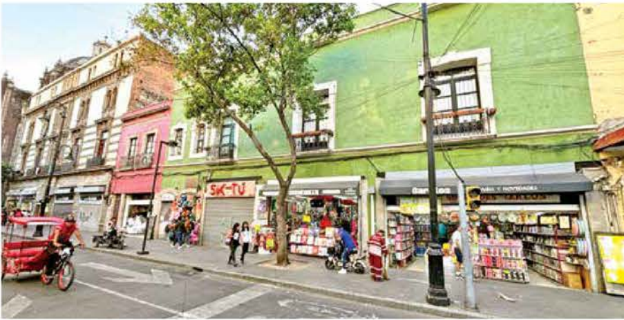
Fachadas de edificios que deberían estar protegidos por leyes patrimoniales sirven como bodegas y aparadores, como en el que nació y murió el poeta Manuel Gutiérrez Nájera.
