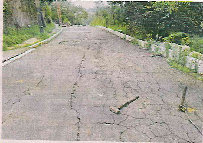
■ Aunque los trabajos en esta colonia de Cuajimalpa ya dieron inicio, aún no se sabe cuándo se concluirán.
