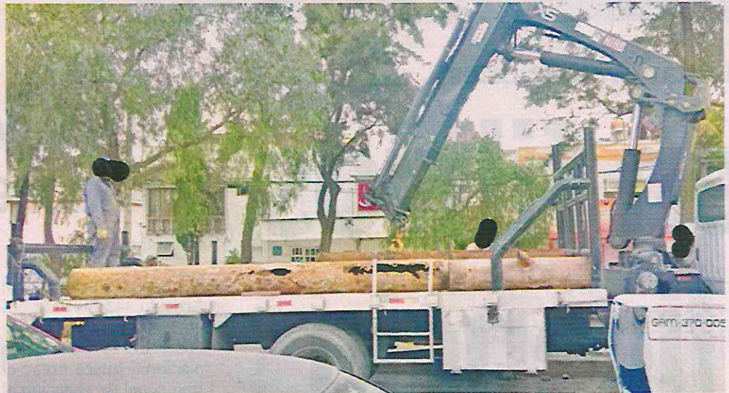
El ducto de turbosina que fue retirado luce visiblemente carcomido y oxidado.
