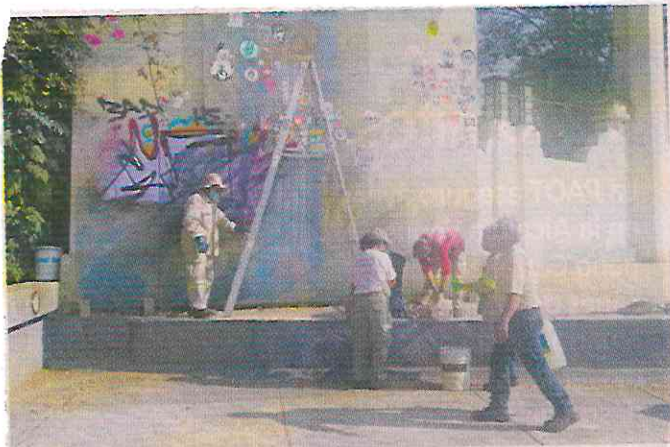
Una cuadrilla de trabajadores comenzó los trabajos de limpieza en el Foro, ubicado en el Parque México.
