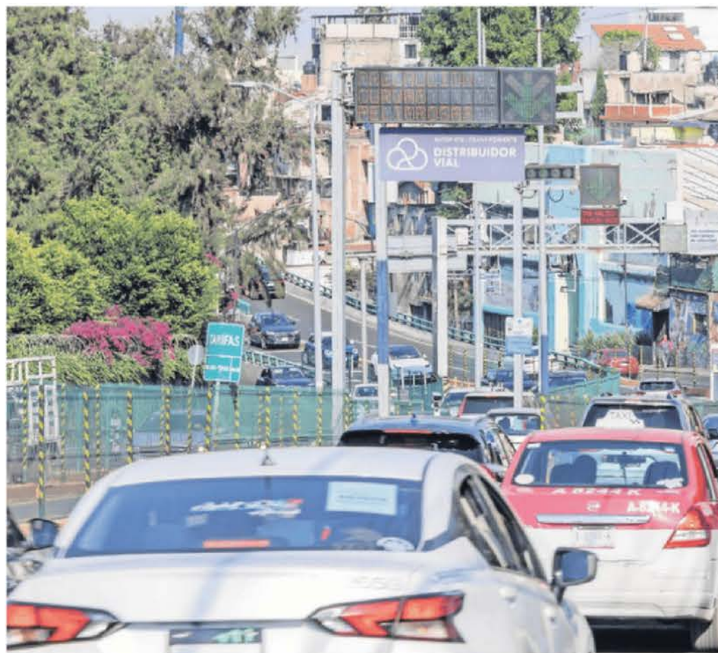
La Ciudad de México cuenta con la Supervía Poniente (en la foto) y las autopistas urbanas Norte y Sur como alternativas de pago para que los automovilistas se trasladen más rápido a sus destinos.
