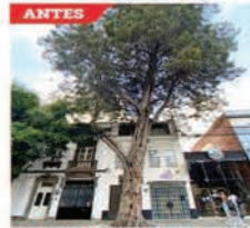
ANTES. En 2021, vecinos alertaron por el riesgo que implicaba el árbol inclinado; el martes, el ejemplar colapsó en plena lluvia.
